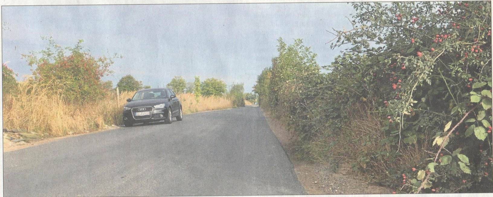
Der schmale Mittelweg an der Kiesgrube Hersel könnte ausgebaut werden und damit den Bahnübergang Hersel entlasten.
