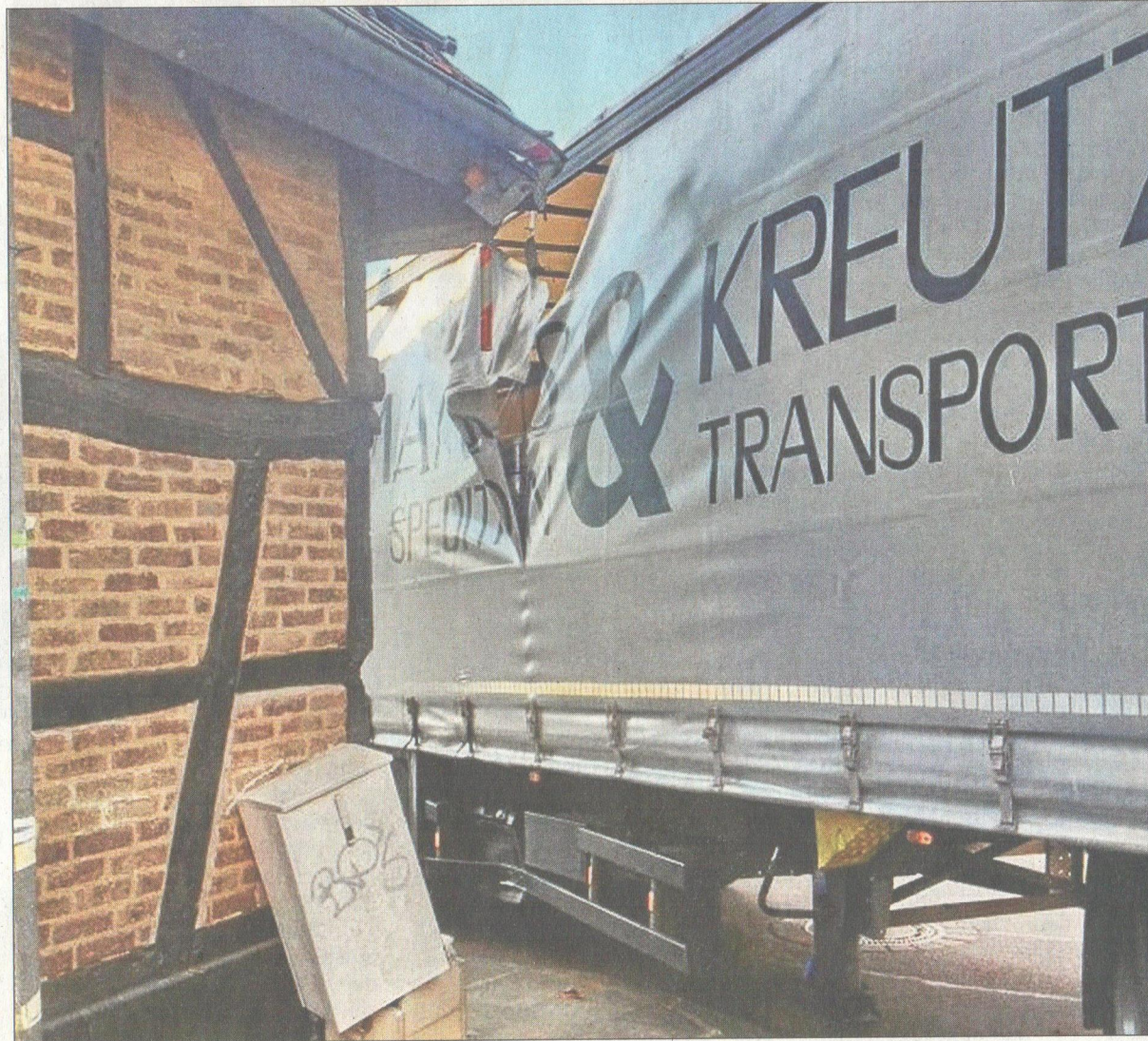
Festgefahren hat sich am 19. Mai ein Laster am Haus an der Ecke von Küppersgasse und Breite Straße in Brenig. Auch der Stromkasten kam dabei zu Schaden.
